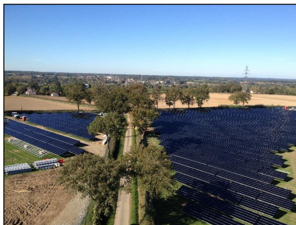
Centrale de Dompierre sur Besbre / Diou
