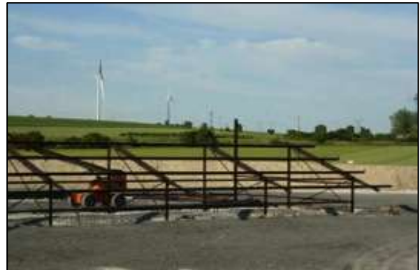
Chantier AER – Automne 2010
